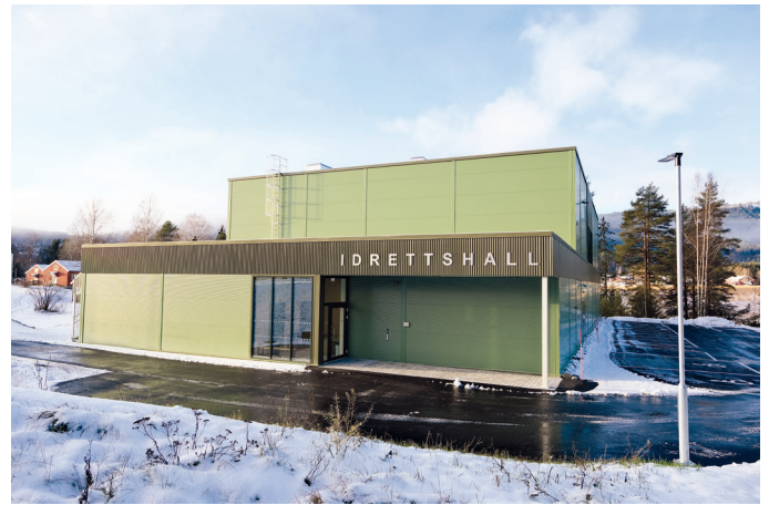
Idrettshallen er bygd i et separat bygg.
