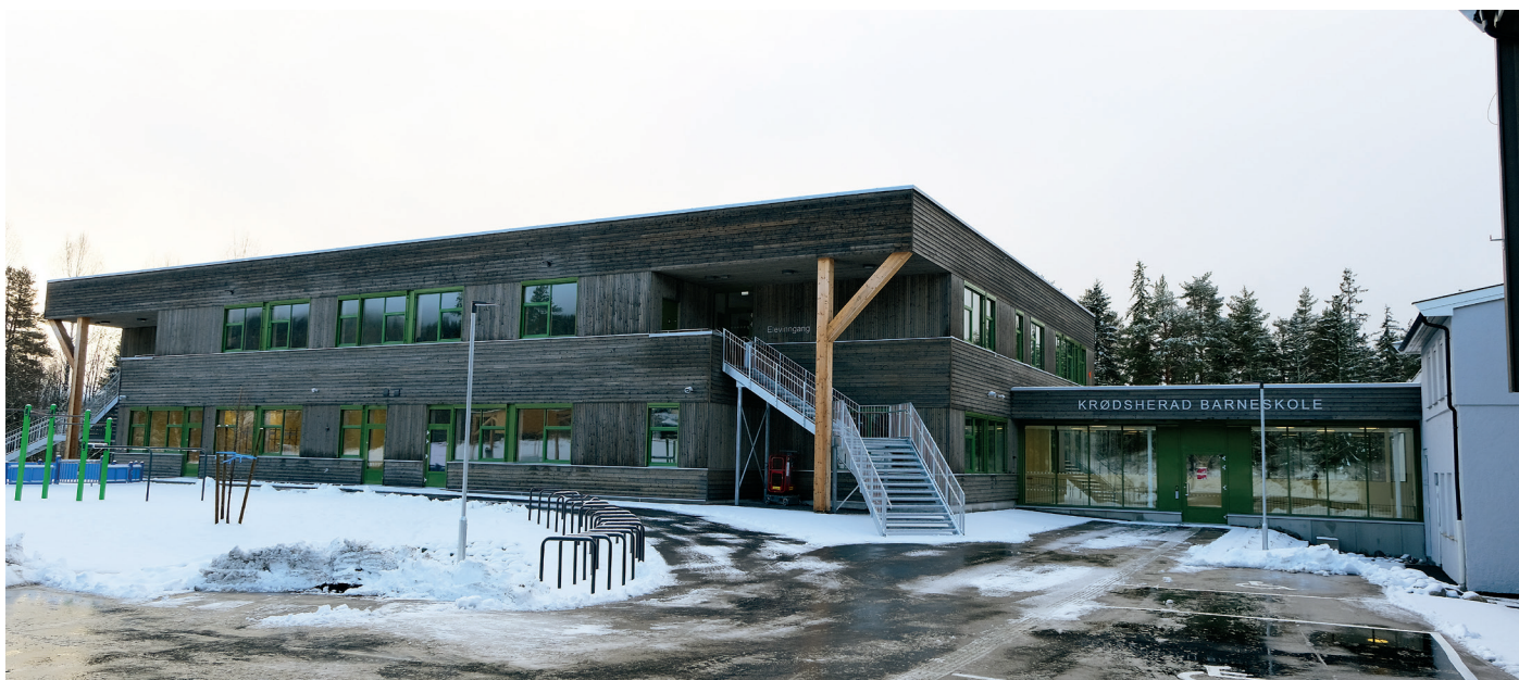
Nybygget har et bruttoareal på 3.200 kvadratmeter fordelt på tre etasjer.
